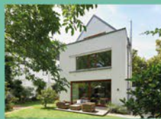
Modernisierung neues Einfamilienhaus
